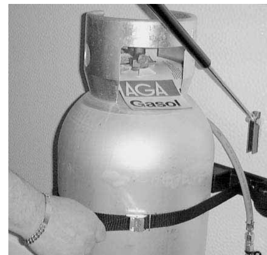
Kontroller at gassflasken er ordentlig festet.
