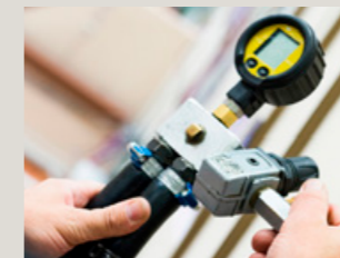
GASSYSTEEM. Het flessengassysteem wordt onder druk getest.
