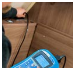
Elektrische Anlage. Die elektrische Anlage und andere wichtige Funktionen werden kontrolliert, bevor die Wohnmobile die Fabrik verlassen.
