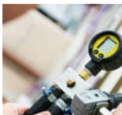
Gassystem. Das Gassystem wird Drucktests unterzogen.
