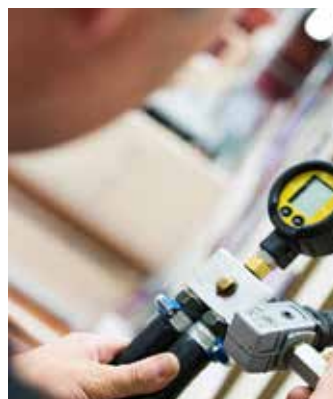
Das Gassystems wird Drucktests unterzogen.
