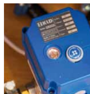
AUTOMATISK TØMMING AV VANNSYSTEMET VANNLÅS TOA Y0374
