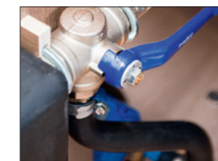
Direkte afløb; forbi kobling spildevandstank
