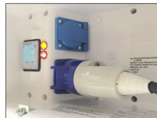
Kilowattmeter in elektriciteitskast
