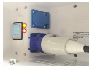
Stromzähler im Schaltkasten
