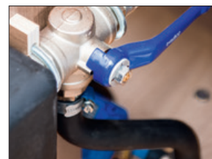
Direkteavløp; forbioppling gråvannstank
