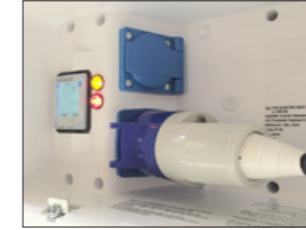
Sähkömittari sähkökoteloon (Vakio Suomessa, Ei Classic)
