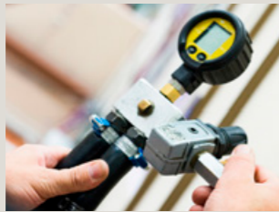
KAASU. Kaasujärjestelmälle tehdään painekoe.
