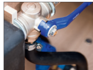
Direkte afløb; forbi kobling spildevandstank
