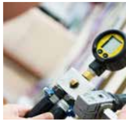
Kaasu. Kaasujärjestelmälle tehdään painekoe.
