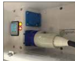
Stromzähler Schaltkasten
