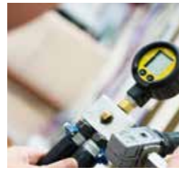
Gassystem. Das Gassystems wird Drucktests unterzogen.
