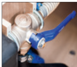
Direktavlopp; förbikoppling gråvattentank
