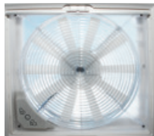
AirVent termostaatilla (makuuhuone) (X0228)
