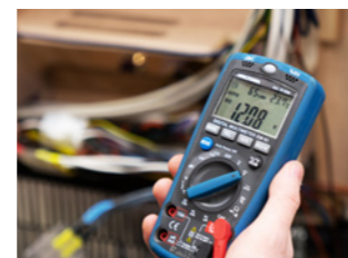
Die elektrische Anlage und andere wichtige Funktionen werden kontrolliert, bevor die Wohnwagen die Produktion verlassen.
