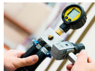
Das Gassystem wird Drucktests unterzogen.
