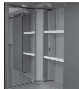
Tarkastusreiä kylpyhuoneen kaapissa.
