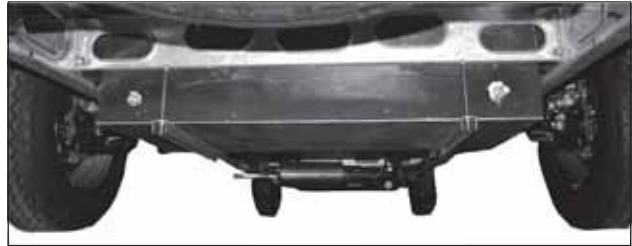
Harmaavesisäiliö on matkailuauton takapyörien välissä.
