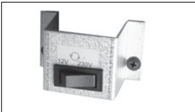
Kiertovesipumpun valintakytkin asunto-osassa.
