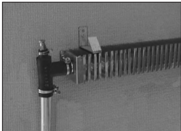
Konvektionsheizkörper und Schlauchanschluss mit Entlüftungsnippel.
