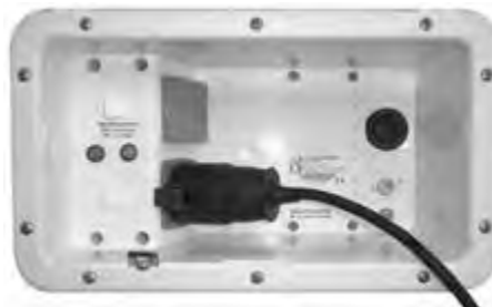
Buitenzijde van de elektriciteitscentrale
