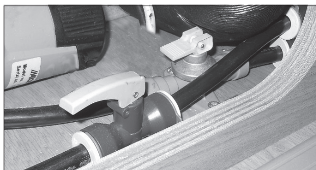
Ablasshähne für Kalt- und Warmwasserschläuche.
