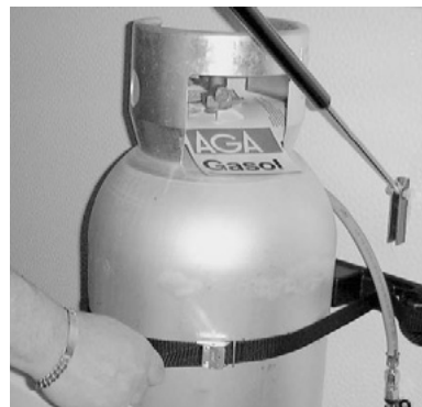
Kontroller at gassflasken er ordentlig festet.
