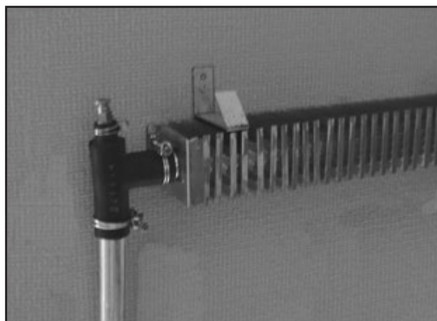
Konvektor og slangetilkopling med luftnippe.
