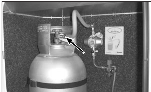
Avaa letkunrikkoverntiilit painamalla painiketta. Jos letkunrikkoverntiili on kiinni, ei kaasulaitteita voi sytyttää.
