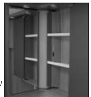
Inspektionshålet placerat i badrumskåpet.
