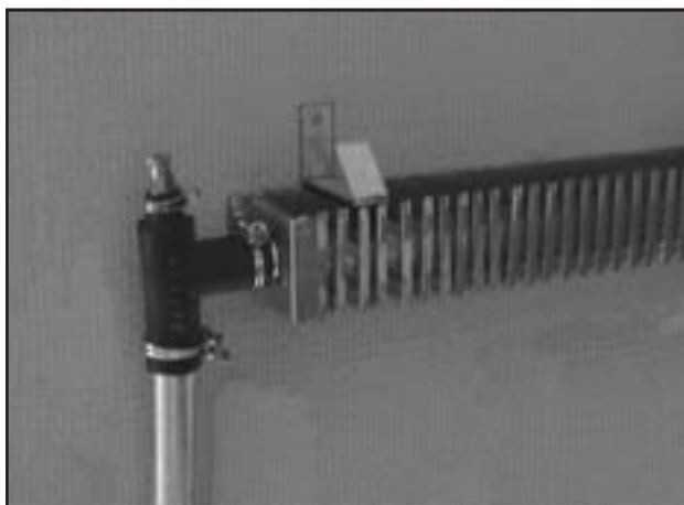
Lämpöpatteri ja letkuliitos ilmausruuveineen.
