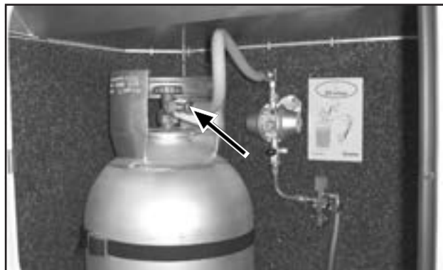
Avaa letkurikkoventtiilit painamalla painiketta. Jos letkurikkoventtiili on kiinni, ei kaasulaitteita voi sytyttää.
