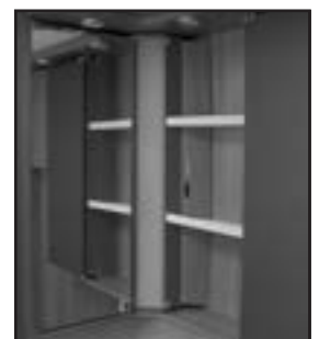
Paisuntasäiliö ja peitelevy tarkastusaukkoineen.
