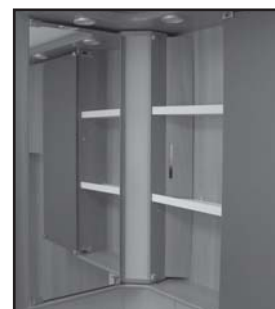
Tarkastusreiä kylpyhuoneen kaapissa.
