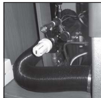
Shunt-Ventil für die Fußbodenheizung (nur bestimmte Modelle).
