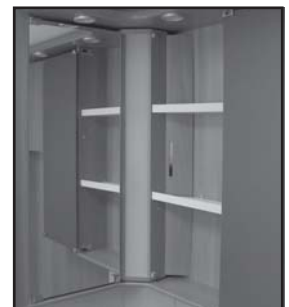
Ausdehngefäß und Blende mit Schauglas.
