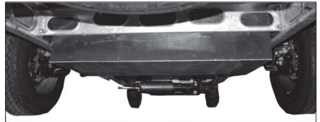
Der Grauwassertank sitzt zwischen den Hinterrädern des Wohnmobils.
