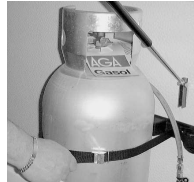
Kontroller at gassflasken er ordentlig festet.
