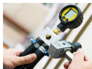
GASSYSTEEM Het flessengassysteem wordt onder druk getest.
