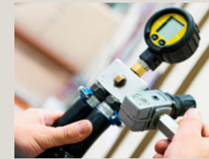
KAASU. Kaasujärjestelmälle tehdään painekoe.
