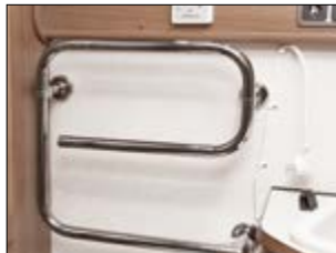
Pyyhkekuivain • Sähkökäyttöinen ajastimella / vesikiertoinen • Sähkö putki 1700 mm
