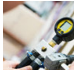
Kaasujärjestelmälle tehdään painekoe.
