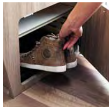
Het schoenvak bij de entree deur is voorzien van een verwarmingsslus.
