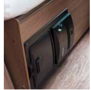
Centrale stofzuiginstallatie Y0349
