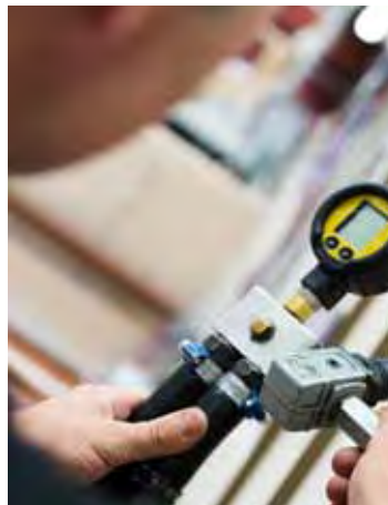
Kaasujärjestelmälle tehdään painekoe.
