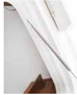
Gasdämpare i bodelsdörr
