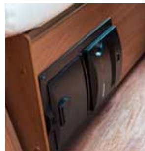
CENTRALE STOFZUIGIN- STALLATIE Y0349
