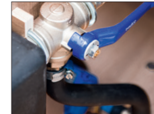
Directe afvoer afvalwater
