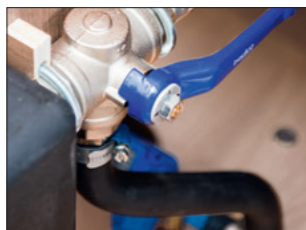
Direkte afløb; forbikobling spille- vandstank (standard Imperial)
