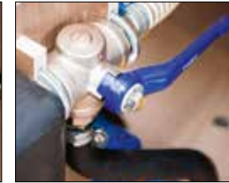
Direkteavløp; forbikopling gråvannstank
