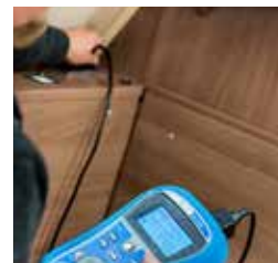
Elsystem. Elsystemet og andre viktige funksjoner kontrolleres før campingvognene og bobilene får forlate fabrikk.
