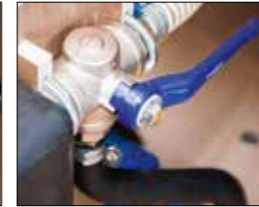
Direkte afløb; forbikobling spildevandstank
