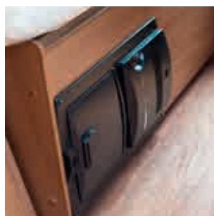
Centrale stofzuig-installatie (X0161)
