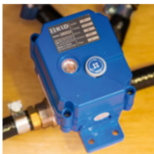
ELEKTRISCHE ENTLEERUNG DES ABFLUSSES
