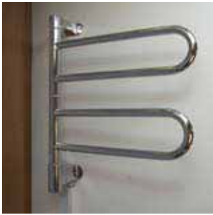
Håndklædetørrer (el) (X0132) Med indbygget varmespiral for hurtigere tørring. Håndklædetørrer (vandbåren) (X0220) Tilsluttet konvektoren. TDL: Anbringes i brusekabinen.
