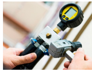
Kaasujärjestelmälle tehdään painekoe.
