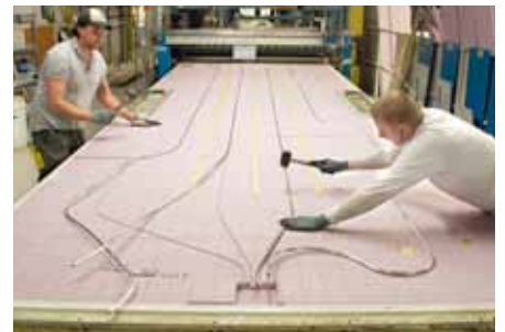
Astrids første arbeidsoppgave har blitt å frese ut sporene for de fire gulvvarmesløyene i isolasjonsmaterialet.
