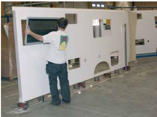
Fönster och luckor förmonteras på väggarna.
