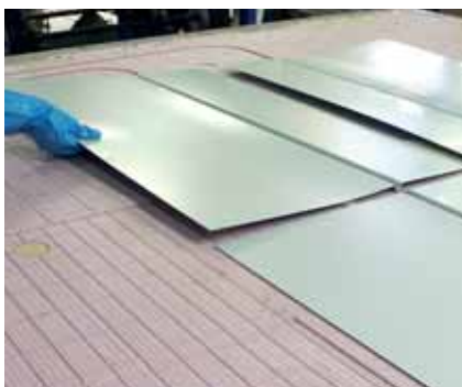
Stora plåtar av aluminium ser till att värmen fördelas ut över golvet.
